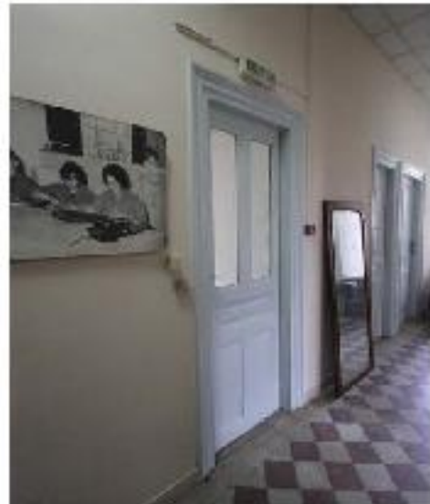
Εσωτερικά ανοίγματα - Άνοιγμα κλιμακοστασίου
