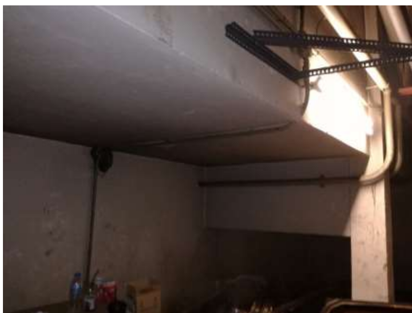
Εικόνα 54 – Υποβιβασμένη πλάκα στο υπόγειο του ΚΤΙ
