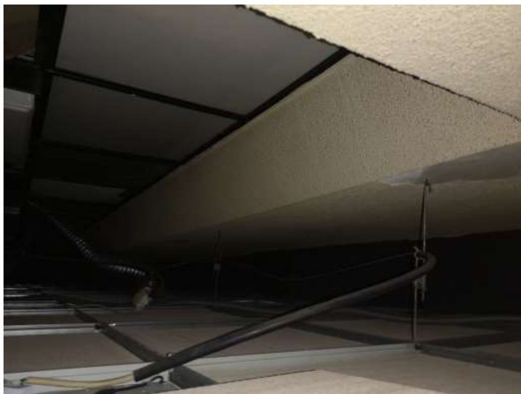
Εικόνα 17 – Στατικά μέλη πάνω από τη ψευδοροφή στην περιοχή του Κδ49 – ΚΤΙΙ
