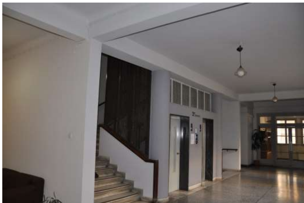
Εικόνα 25 – Κεντρικό κλιμακοστάσιο 3 ος όροφος – ΚΤΙΙ
