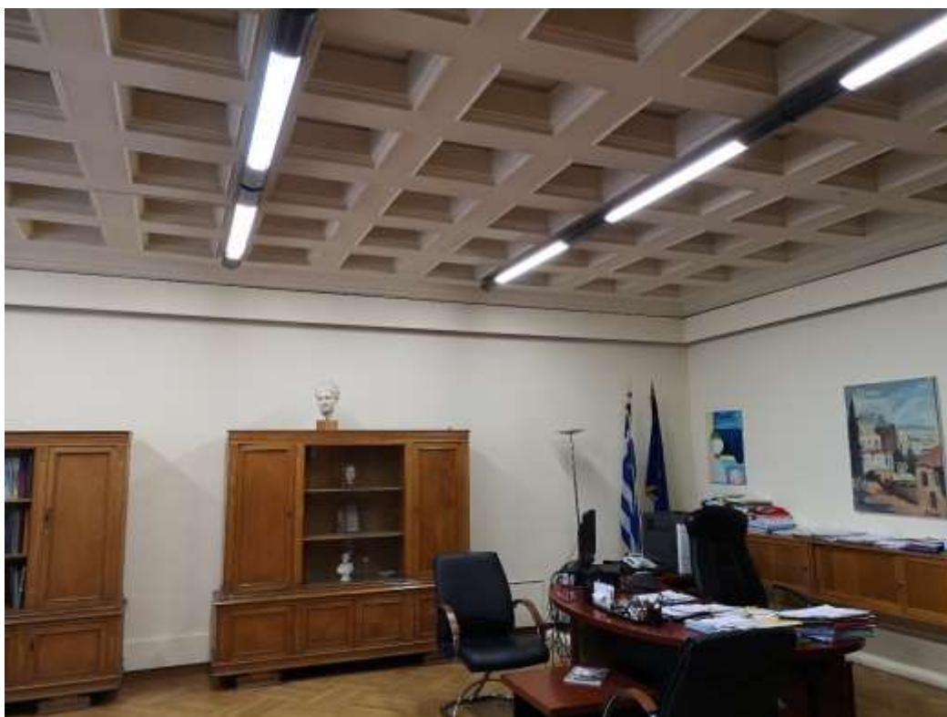
Εικόνα 20 – Υπερυψωμένη πλάκα zoellner στο ΚΤΙ
