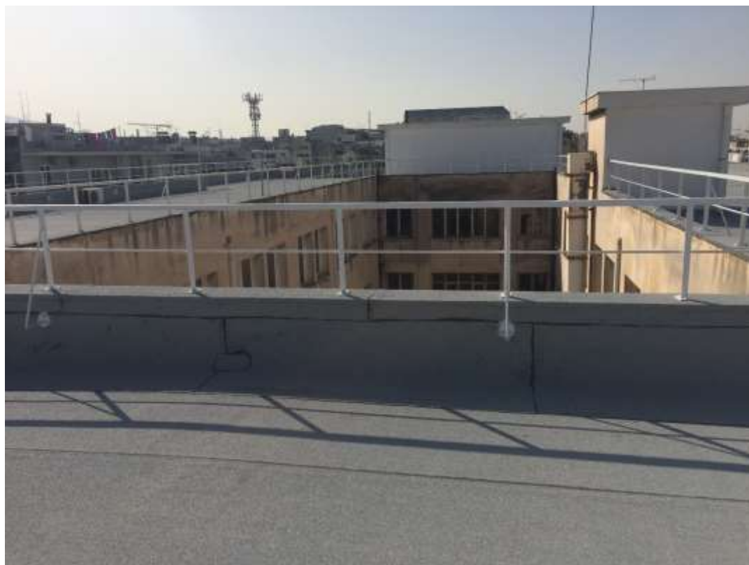
Εικόνα 43 – Γενική άποψη δώματος- αίθριο ΚΤΙΙ
