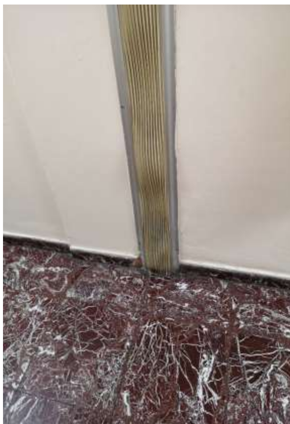
Εικόνα 23 – Άποψη 2 ου όροφου – ΚΤΙΙ και αρμός διαστολής μεταξύ των κτιρίων
