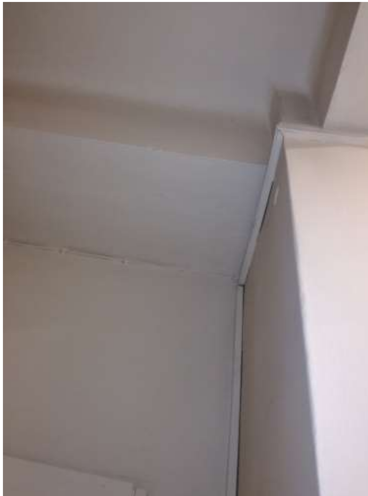
Εικόνα 57 – Διαπλάτυνση δοκού μέχρι την τοιχοποιία
