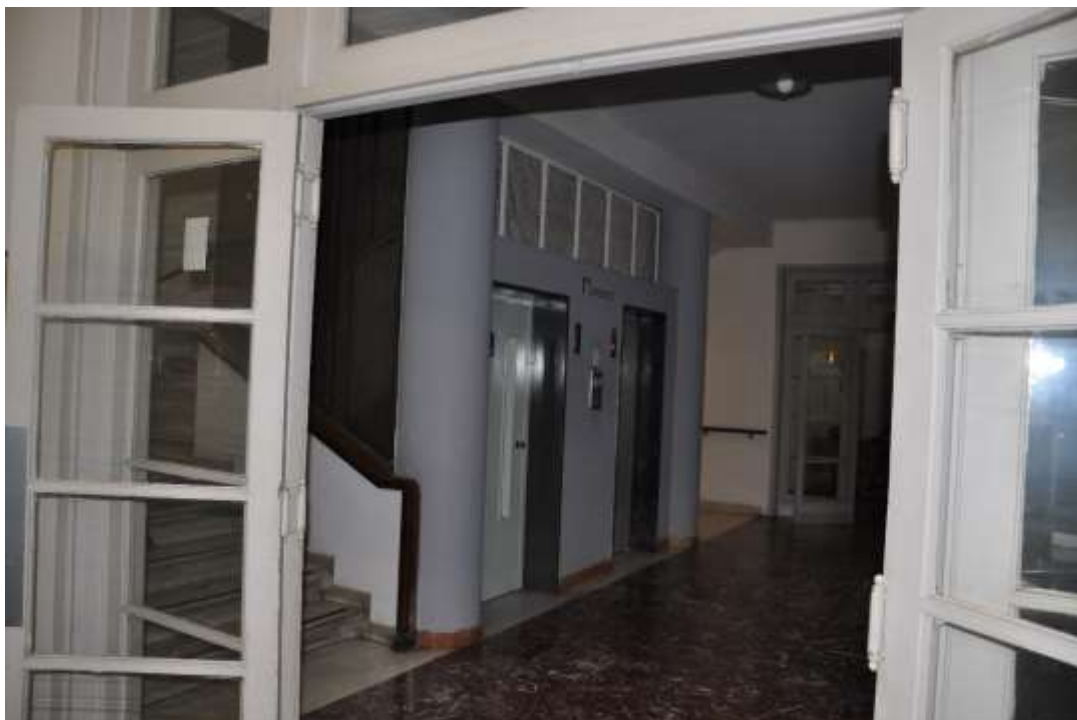
Εικόνα 19 – Κεντρικό κλιμακοστάσιο 1 ος όροφος - ΚΤΙΙ
