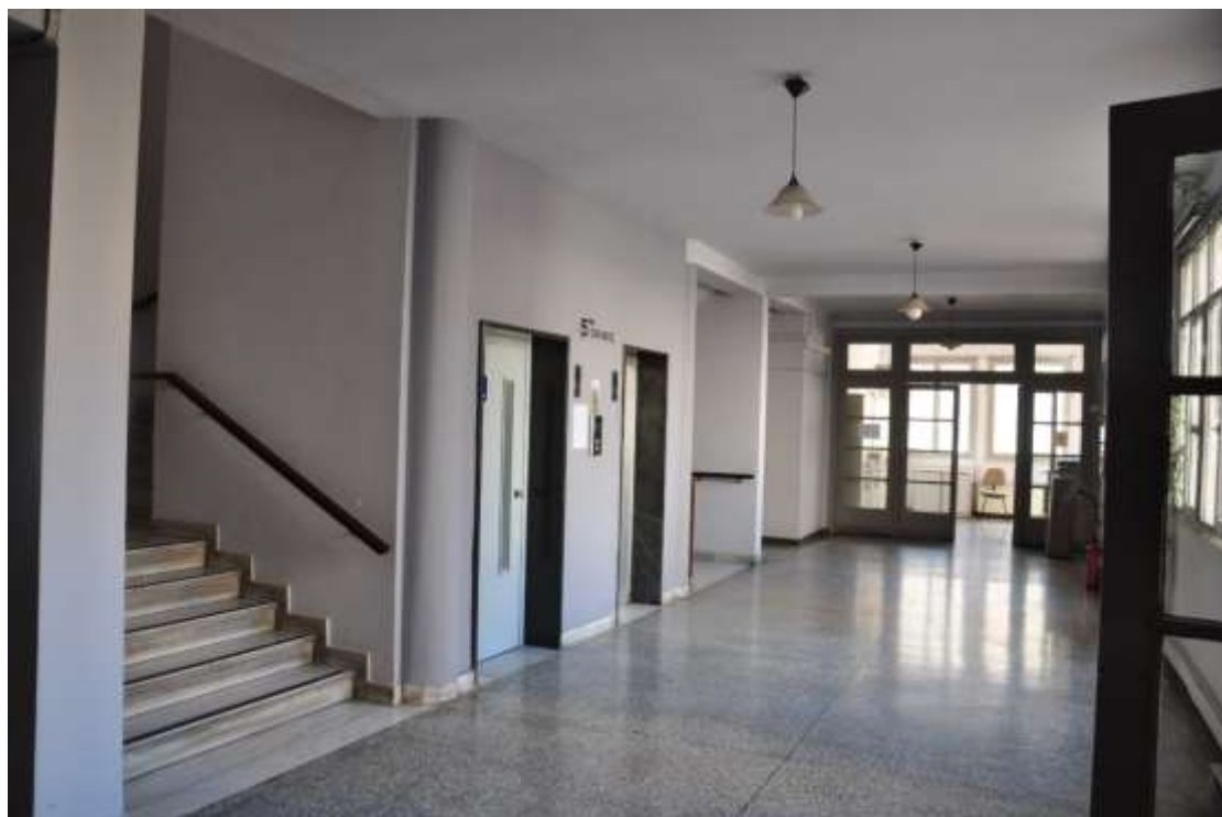
Εικόνα 33 – Κεντρικό κλιμακοστάσιο 5 ος όροφος – ΚΤΙΙ
