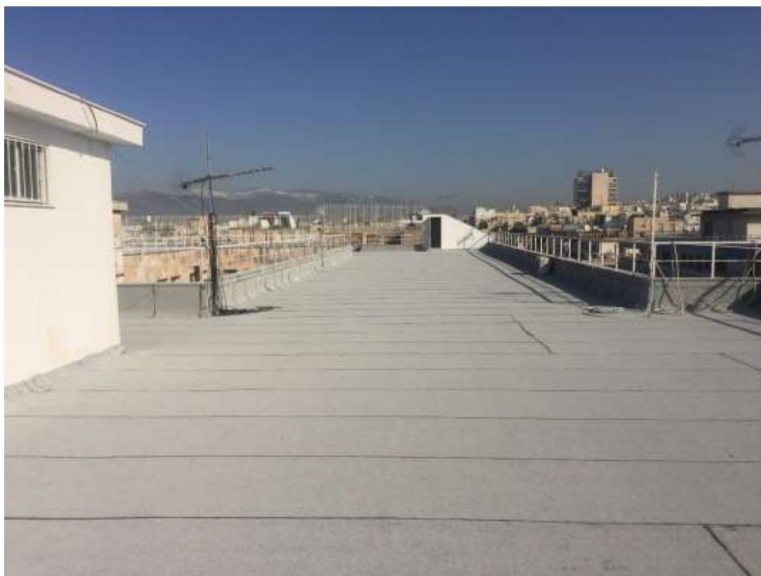
Εικόνα 42 – Γενική άποψη δώματος
