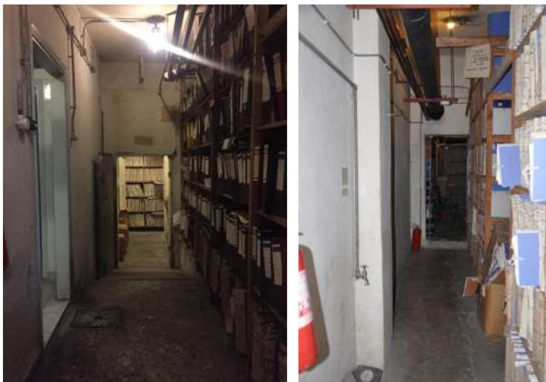
Εικόνα 12 – Στάθμη στην περιοχή που χαρακτηρίζεται ως καταφύγιο
