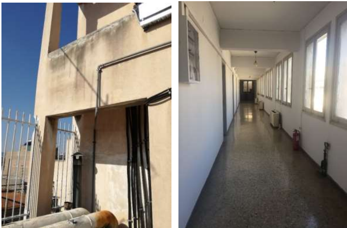
Εικόνα 39 – 6 ος όροφος ΚΤΙ και απόληξη κλιμακοστασίου και διάδρομος στο ΚΤΙΙ
