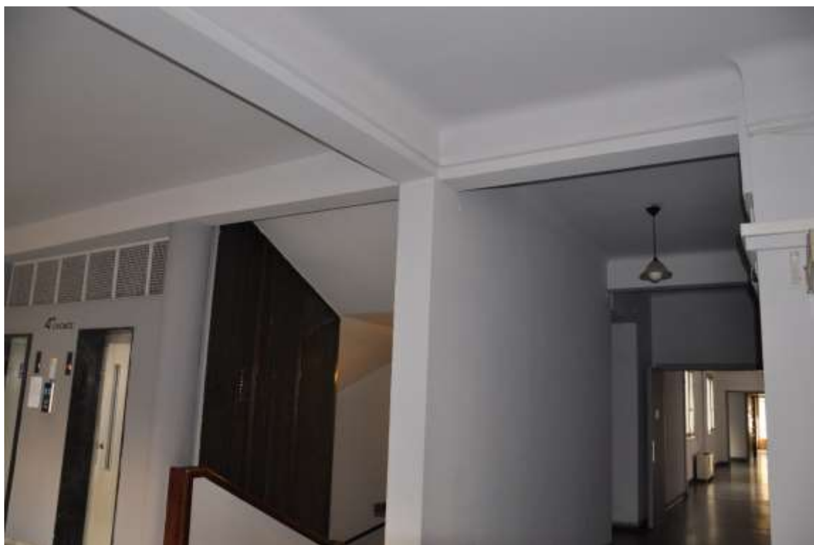
Εικόνα 28 – Κεντρικό κλιμακοστάσιο 4 ος όροφος – ΚΤΙΙ
