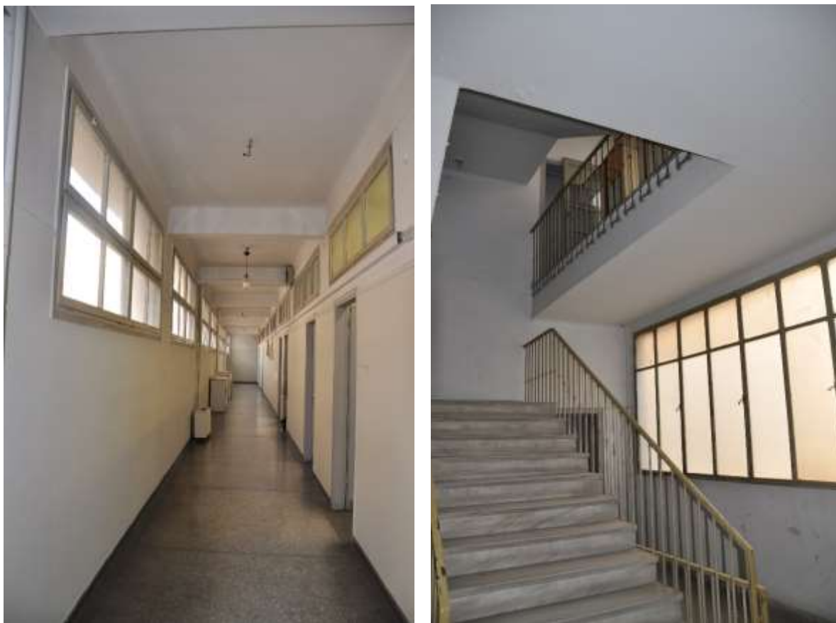
Εικόνα 26 – Άποψη 3 ου όροφου διάδρομος – ΚΤII και κεντρικό κλιμακοστάσιο ΚΤI
