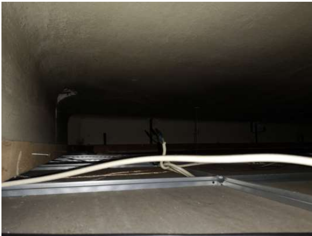
Εικόνα 18 – Στατικά μέλη πάνω από τη ψευδοροφή στην περιοχή του Κδ49 – ΚΤΙΙ
