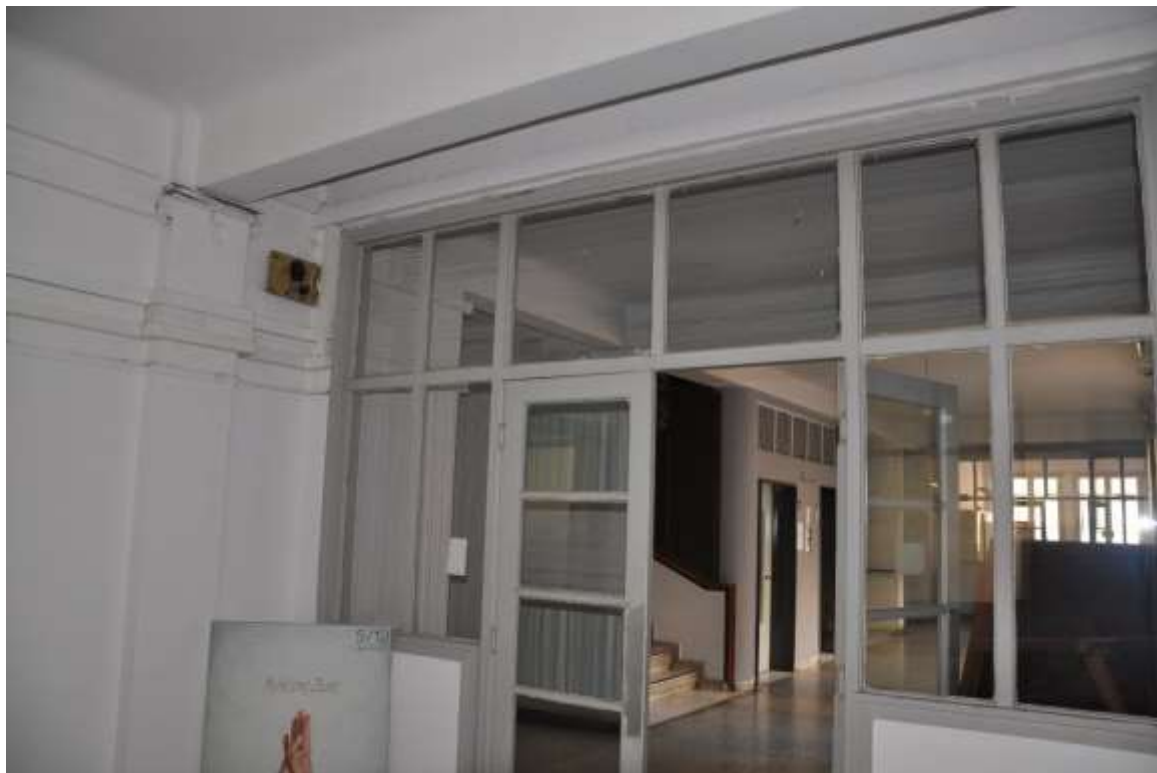
Εικόνα 29 – Κλιμακοστάσιο 4 ος όροφος, ΥΠΟΣΤΥΛΩΜΑ Κ628 – ΚΤΙΙ
