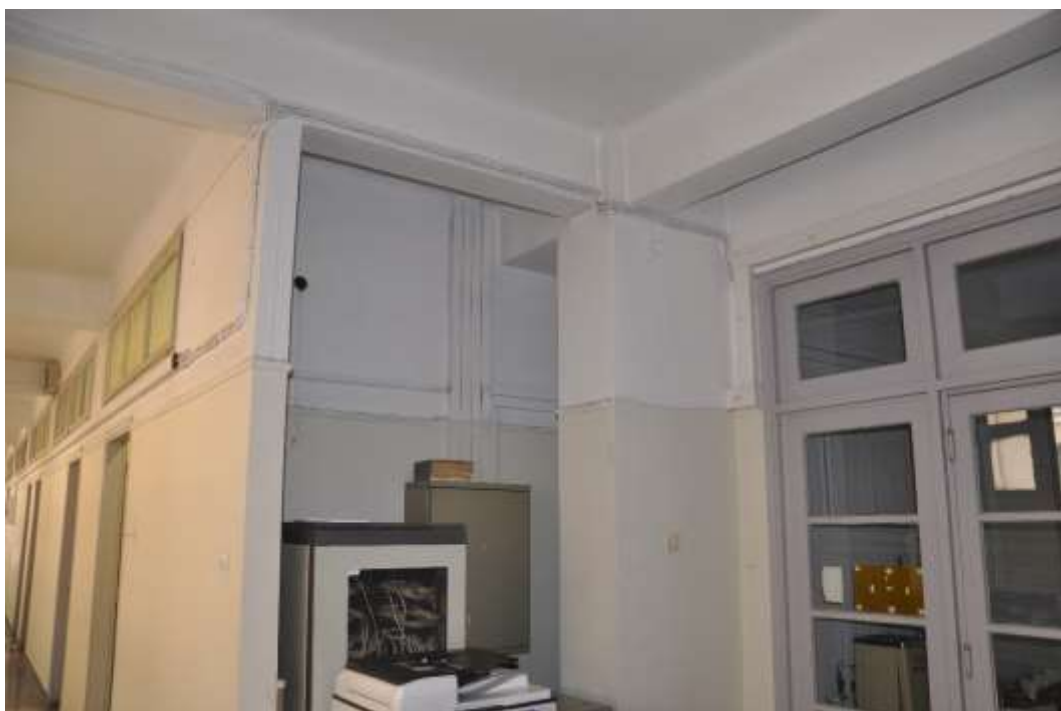
Εικόνα 24 – Υποστύλωμα Κ669 περιβαλλόμενο από τοιχοποιία – 3 ος όροφος ΚΤΙΙ
