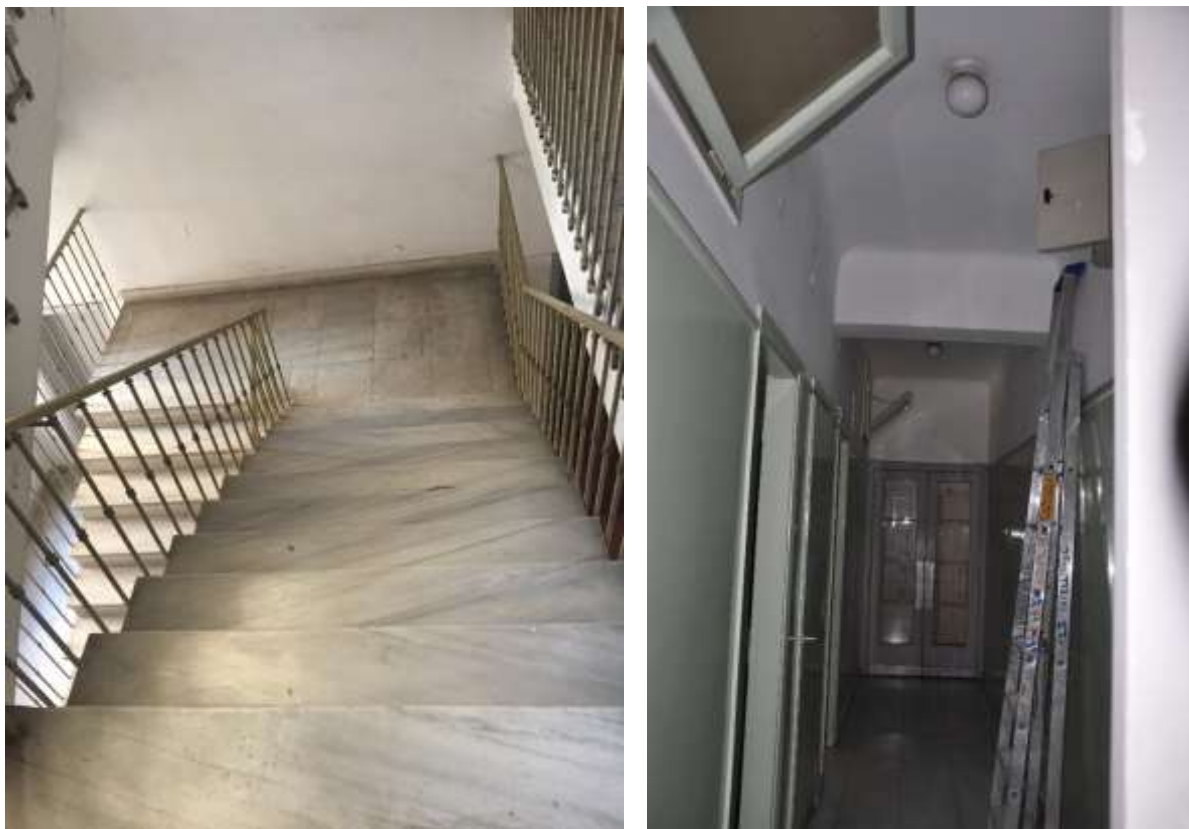
Εικόνα 36 – Πλατύσκαλο κλιμακοστασίου ΚΤΙ και περιοχή πίσω από το κλιμακοστάσιο ΚΤΙΙ
