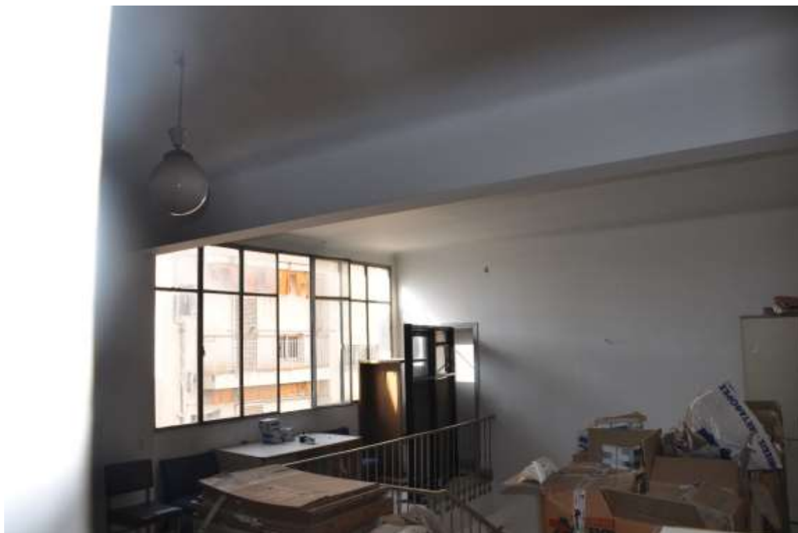
Εικόνα 37 – Τελική στάθμη κλιμακοστασίου ΚΤΙ - 5 ος όροφος
