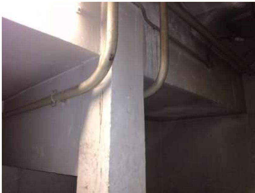
Εικόνα 53 – Υποβιβασμένη πλάκα στο υπόγειο του ΚΤΙ
