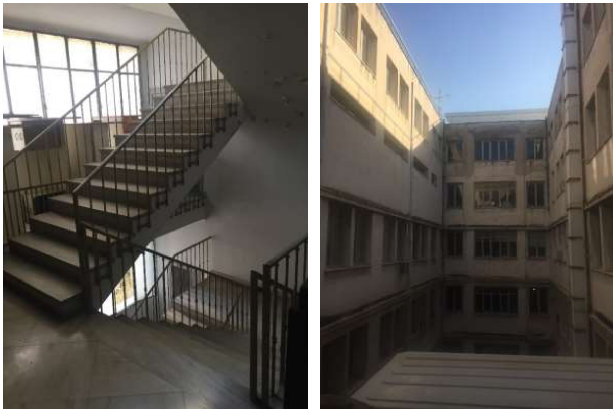
Εικόνα 32 – Κλιμακοστάσιο 4 ος όροφος ΚΤΙ και γενική άποψη αιθρίου ΚΤΙΙ
