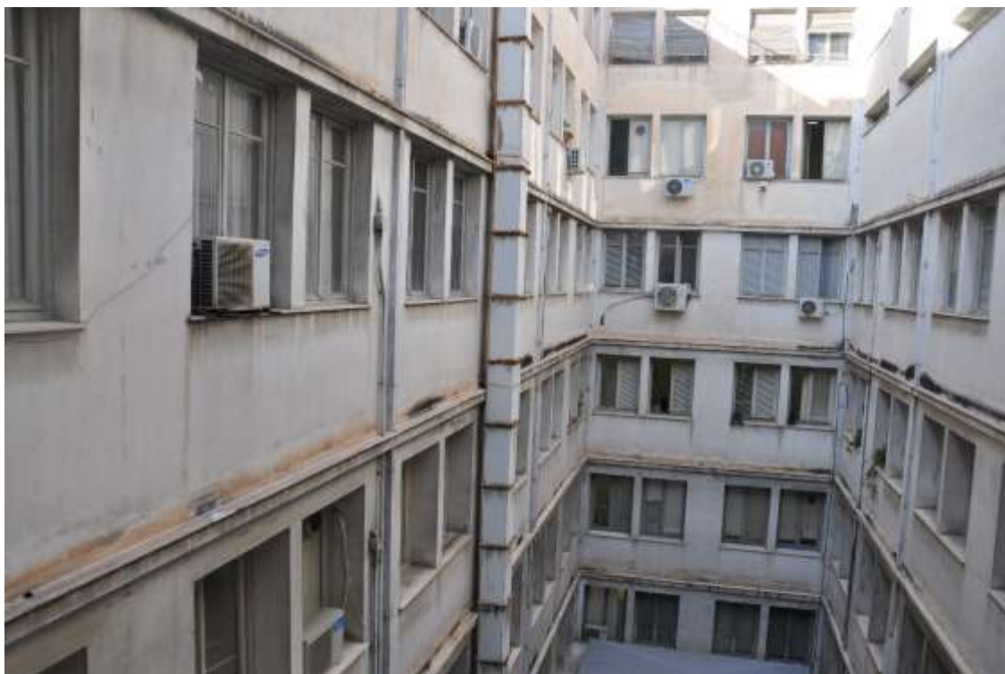
Εικόνα 27 – Άποψη αιθρίου διάδρομος – ΚΤII
