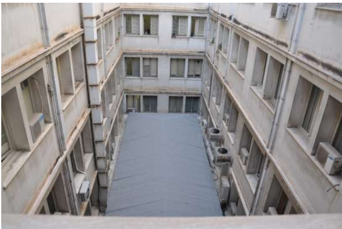
Εικόνα 51 – Άποψη αιθρίου και στέγαστρο στο ΚΤΙΙ
