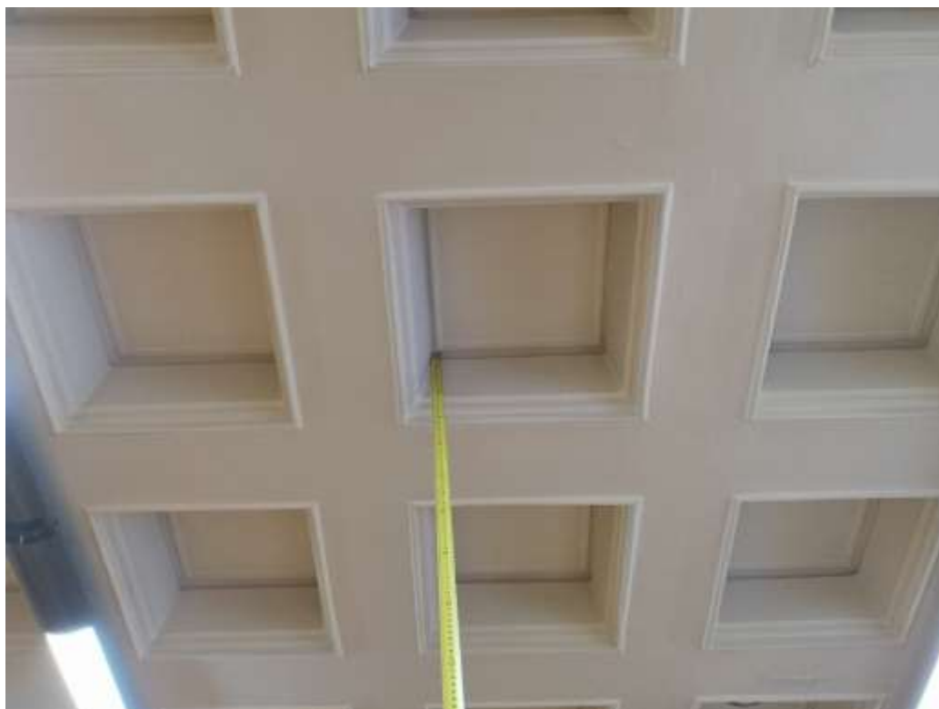
Εικόνα 21 – Υπερυψωμένη πλάκα zoellner στο ΚΤΙ
